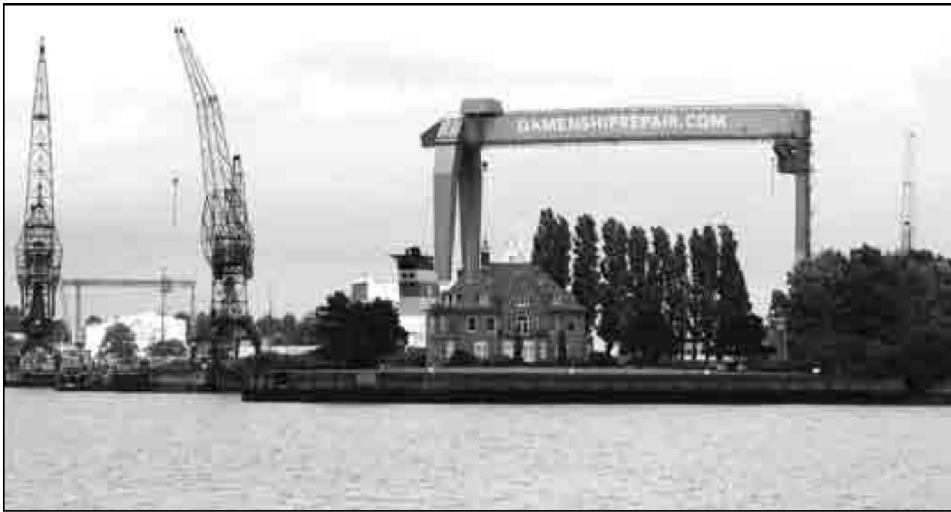
De scheepsbouw- en reparatiebedrijven in Rotterdam, Amsterdam, IJmuiden en Sliedrecht kunnen nog dit jaar een interventieteam over de vloer verwachten.
